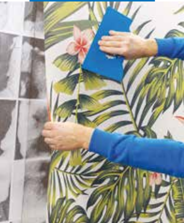
Posa di fibra di vetro decorativa su ceramica esistente
