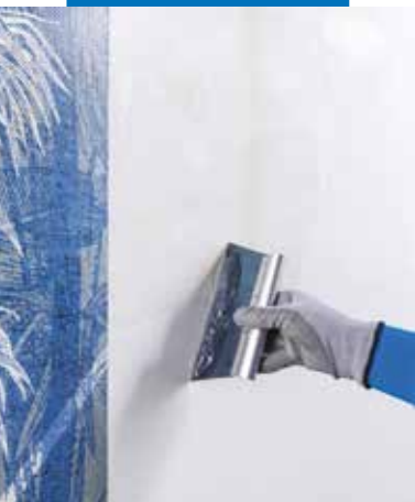
Stesura di Ultrabond Eco Decor Wet su liscivatura a base cementizia
